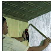
Saubere Abschnitte bei Wand- und Deckenplatten.
